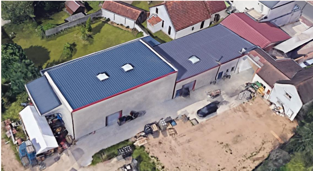
Le projet: 60 kWc, 270 m 2 de panneaux répartis sur les 2 hangars
