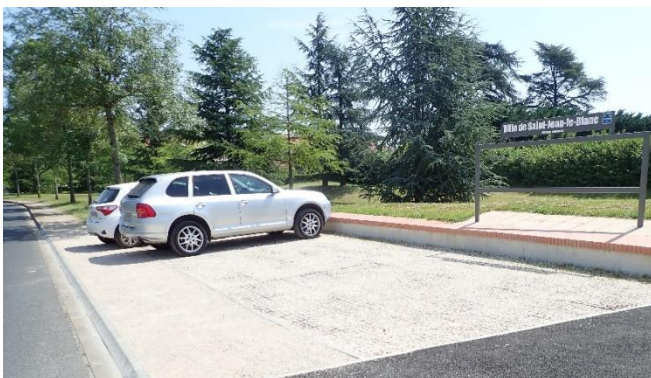
Figure 1- Parkings perméables - SAINT JEAN LE BLANC (gauche, ©LNE) & BLOIS (droite, © CDPNE)
