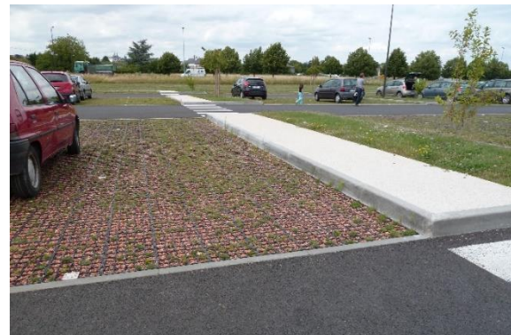
Figure 1- Parkings perméables - SAINT JEAN LE BLANC (gauche, ©LNE) & BLOIS (droite, © CDPNE)
