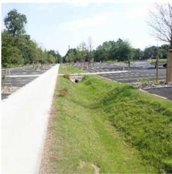
L'une des premières mesures à prendre pour éviter la pollution des eaux de pluie est donc de limiter au maximum le ruissellement, et d'infiltrer l'eau au plus près de l'endroit où elle tombe grâce à des surfaces perméables. Le décret du 29 décembre 2015 relatif à la modernisation des plans locaux d'urbanisme (PLU) permet aux règlements des PLU d'imposer à un projet des surfaces minimales non imperméabilisées.
