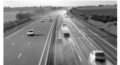
Comparaison entre une route en enrobé bitumeux poreux et une route en enrobé bitumeux classique
