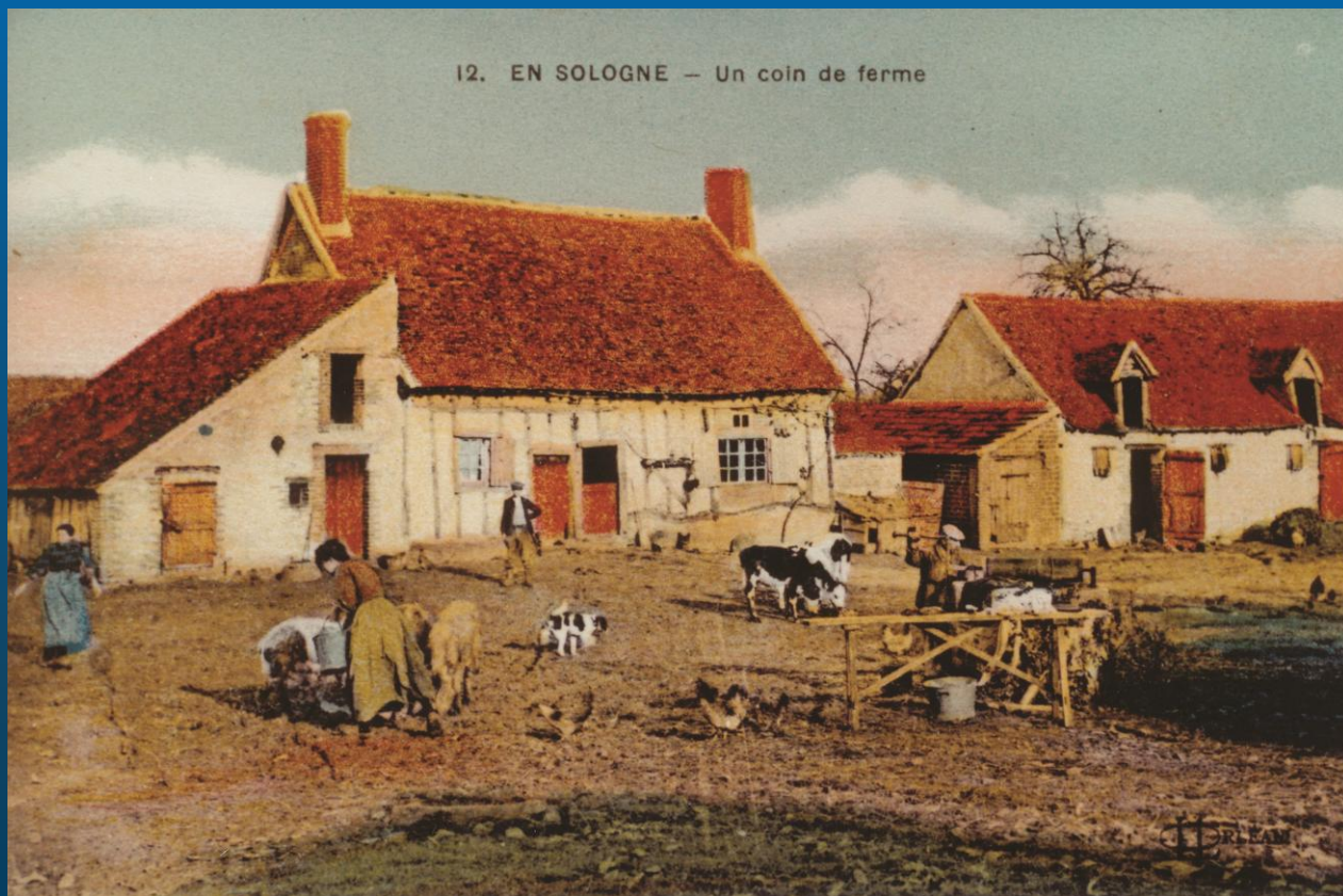
Ferme de la Tuilerie, Ligny, 1920
